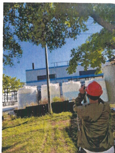
锅炉废气排放口 DA003
